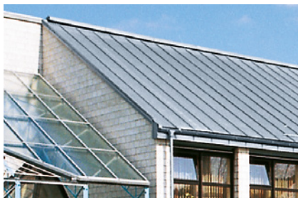
Faîte à 1 pan avec tasseau au faite
