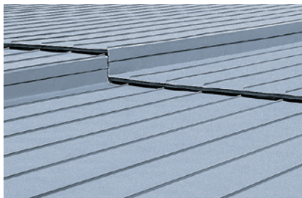
Agrafes transversales et ressauts de dilatation
