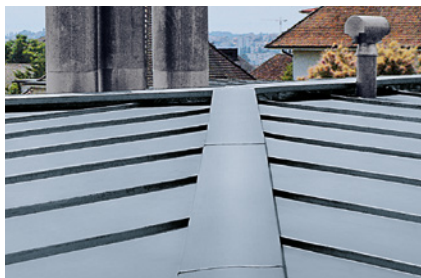
Arêtier avec recouvrement plus large, avec ou sans ventilation de l'arêtier
