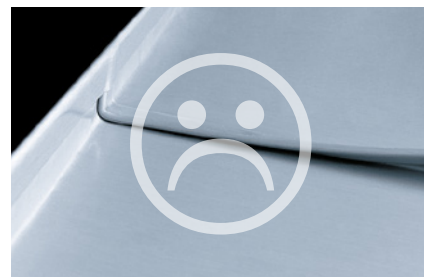
Faîte à 1 pan sans mouvement avec hauteur trop faible
