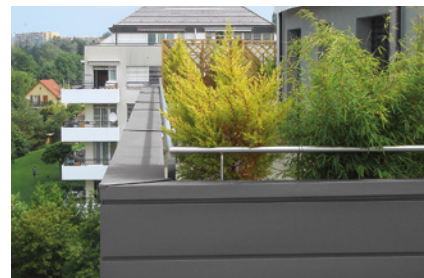
Bordures de toits plats et recouvrements de murs en RHEINZINK
