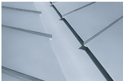
Noue encastrée sur couche de séparation structurée
