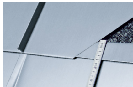
Agrafe transversale simple (pour petites largeurs et pente suffisante)
