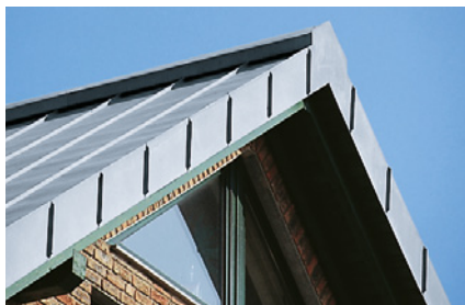
Faîte, exécution avec ventilation
